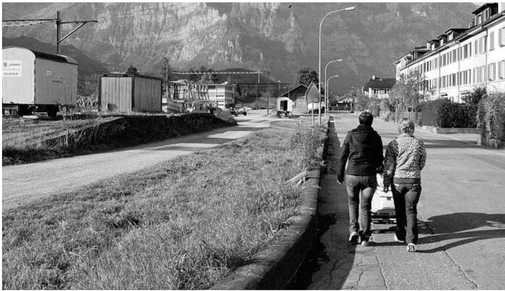
Autos statt Gras: Neben der zu sanierenden Bahnhofstrasse entstehen neue Parkplätze.
